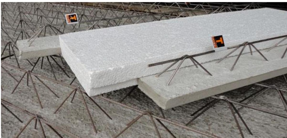
**Figura 2** – Laje Treliçada com inerte de EPS.
