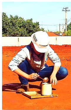
Figura 20: Retirada de areia do furo - fonte: próprio autor (2017).
