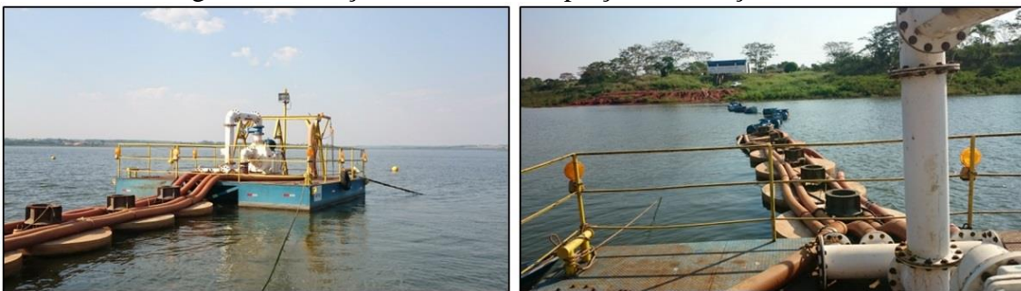
Figura 3 – Estação flutuante de captação em Araçatuba, rio Tietê
