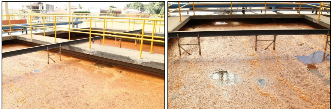
Figura 6 – Detalhe do sistema de floto-filtração
