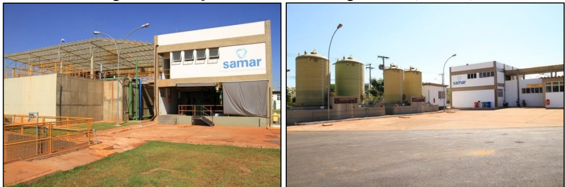
Figura 5 – Estação de tratamento de água Tietê (ETA III)
