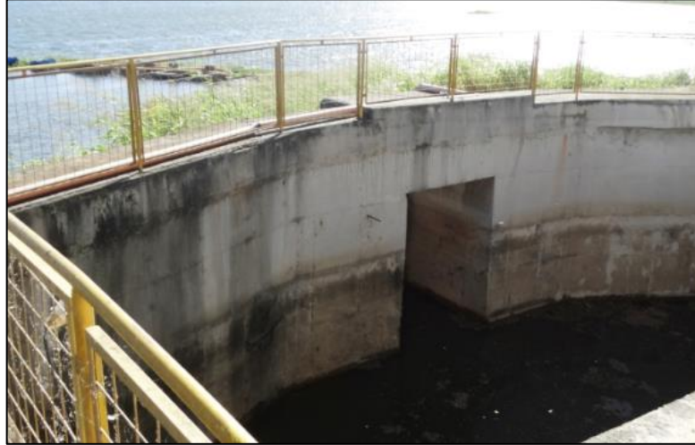
Figura 4 – Estação tradicional de captação de água em Araçatuba, rio Tietê
