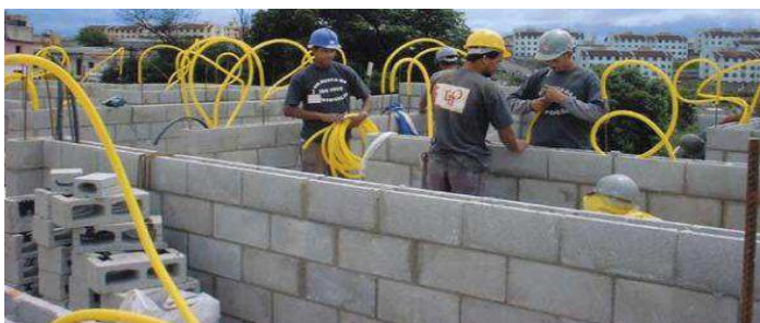
Figura 10. Passagem dos conduítes site: EBAH.
