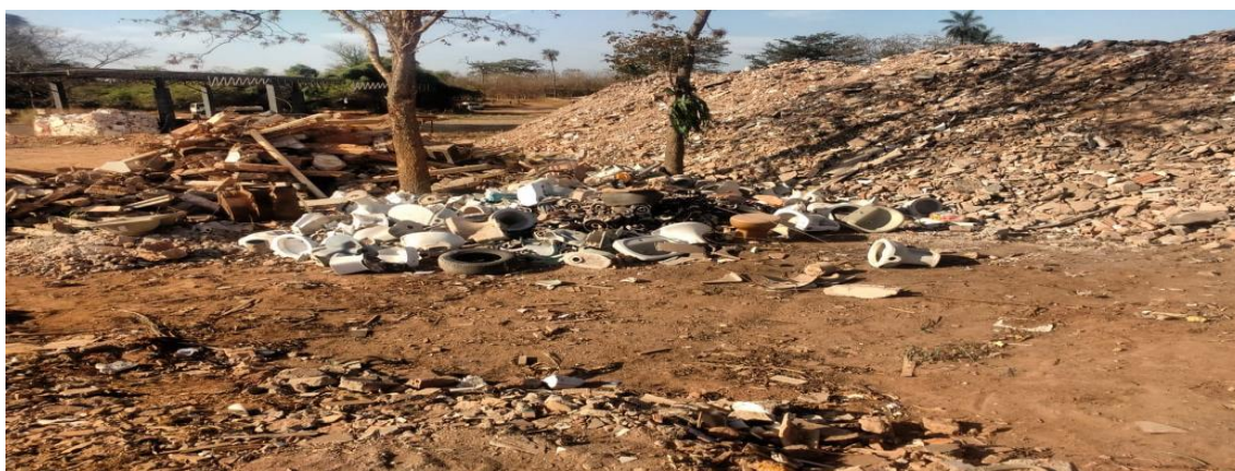
Figura 4: Separação de pneus, madeiras, concretos e tijolos.
