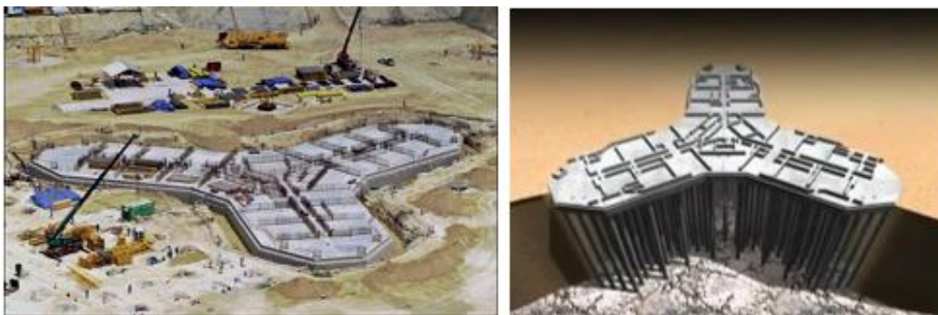
Figura 7 – Fundação do edifício Burj Khalifa Bin Zayid. Fonte: Souza, F. (2014)
