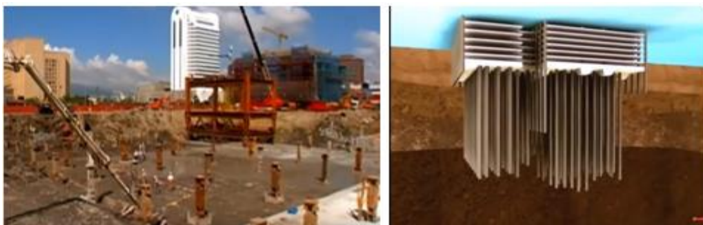
Figura 6 – Fundação do edifício Taipei International Financil Center. Fonte: Taipei...(2015)
